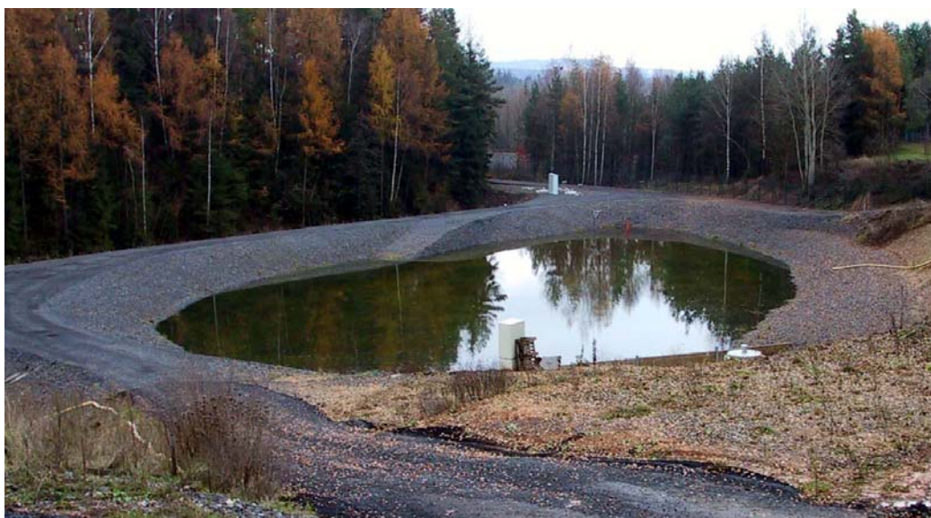
Sickerwasserbecken für Bauabschnitt C
